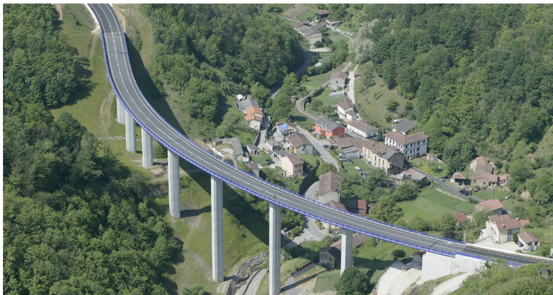
El Nalón Corridor, Asturias
