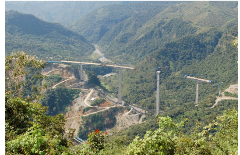
San Marcos Viaduct (México)
